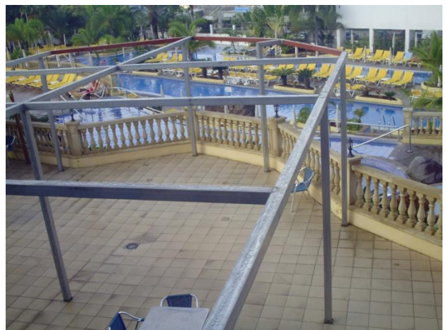
Konstruksjonen til "utvidelsen".
